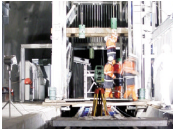
Figure 4. Descente de point par voie mécanique
